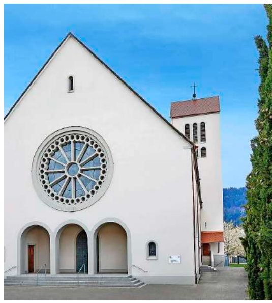
Die Sanierung der Fassade der Freiburger Dreifaltigkeitskirche wurde von der Firma Kiefer 2020 umgesetzt.
